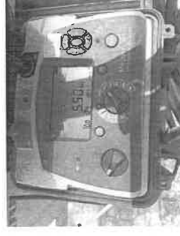
ค่าความดันของหม้อแปลงไฟฟ้าแรงสูงกับแรงต่ำ HV-LV
